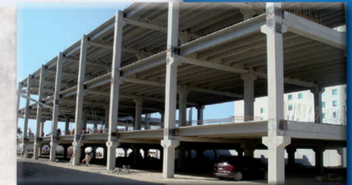
Columnas, Traveses y Losas TT
